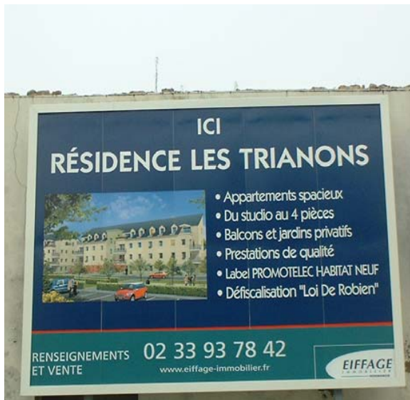
65 logements en chantier, en centre-ville
