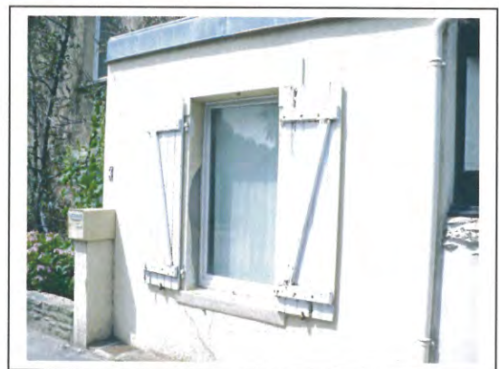
Percements – Croisées à grands carreaux
