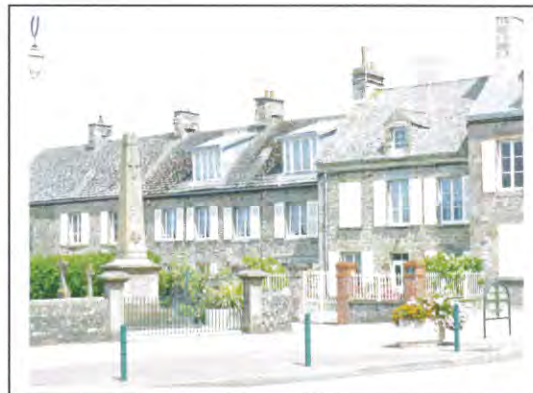
Une succession de percements en façade
