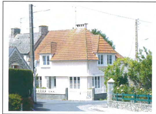
Toiture en tuiles mécaniques
