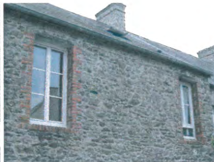
Encadrements de portes et fenêtres en briques
