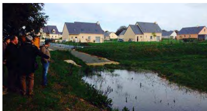
Bassin de rétention du lotissement des Corbières 1, en amont du vallon.
