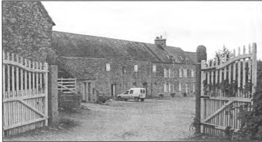
Corps de ferme « Le Buisson »
