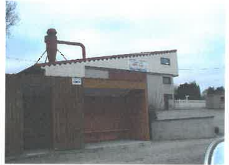
Une entreprise de menuiserie
