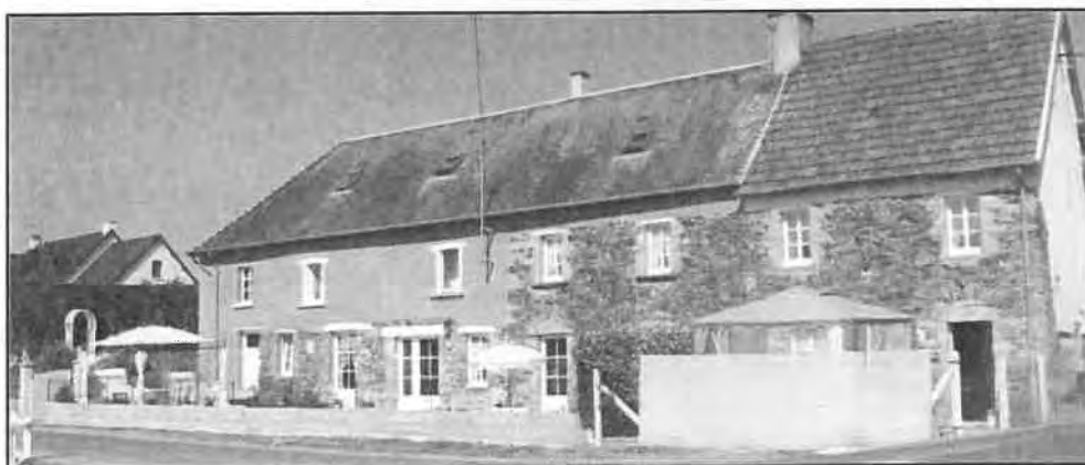
Maison en pierre et en masse à La Croix Périer
