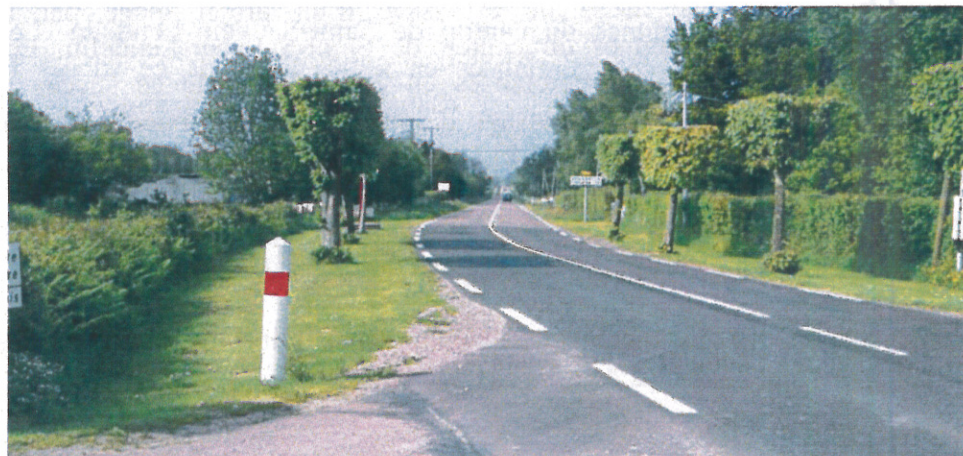
En direction de Périers, l'aménagement d'entrée de ville, avec des arbres taillés alignés le long de la RD se prolonge quelque peu au delà du carrefour.
