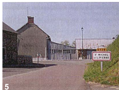
1. Vue du CR n°5 à gauche sur la RD 391 2. Vue du CR n°5 à droite sur la RD 391 3. Vue du CR n°5 à droite sur la RD 139 et le débouché en biais 4. La place de la mairie gravillonnée 5. EB10 et EB20 sont sur le même support et le panneau AB1 est à 1m du sol 6. Au débouché de la RD 57 sur la RD 53, la visibilité est insuffisante.
