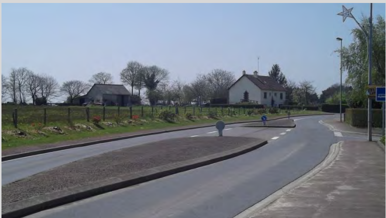
La RD30: un îlot central permet la traversée de la voie pour relier la résidence des 3 Provinces
