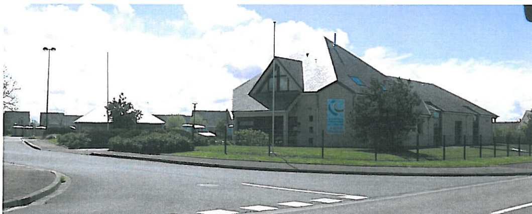
La maison de la Communauté de Communes
