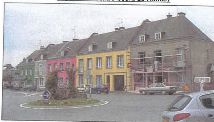
Façades du centre-bourg de Roncey
