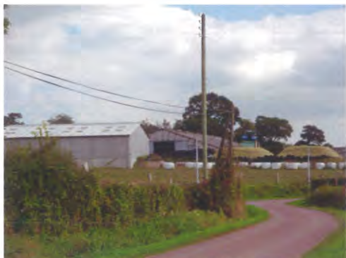
Exploitation au lieu-dit « La Rue de Tourville »
