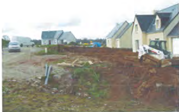
Lotissement à l'entrée Sud-Ouest du bourg
