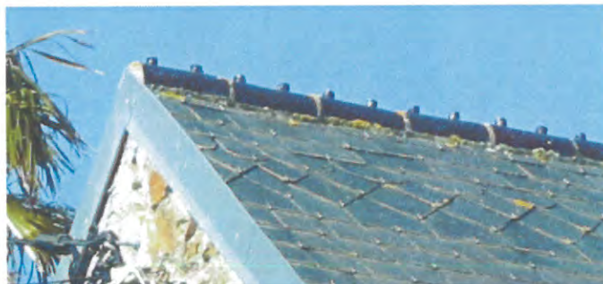
Faîtage en tuile rondes ornées de boutons, spécifique du Cotentin
