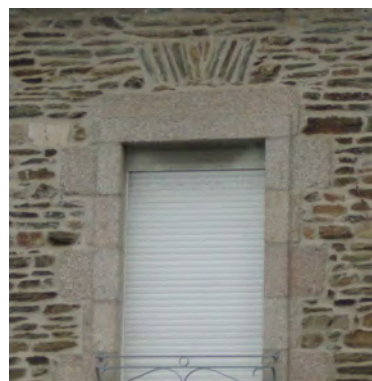
Linteau de décharge en pierre
