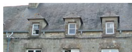
Systèmes de gouttières intégré
