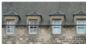
Systèmes de gouttières à proscrire
