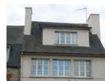
Différents types de lucarnes, les plus récentes sont à un pan : à éviter
