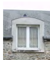
Différents types de lucarnes, les plus récentes sont à un pan : à éviter
