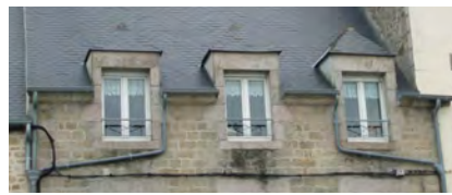
Systèmes de gouttières à proscrire
