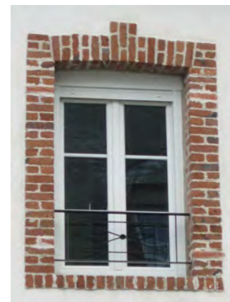
Linteau en brique structurel
