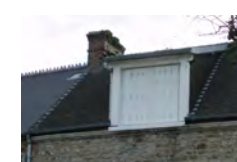
Différents types de lucarnes, les plus récentes sont à un pan : à éviter
