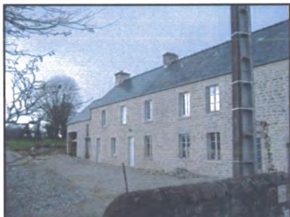
Ancienne bâtisse en cours de restauration - La Trouderie
