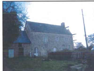
Maison en cours de rénovation - hameau Panville
