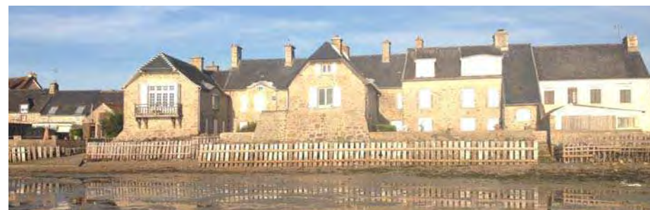
Le Rivage vu depuis l'estran : les jardins des maisons sont protégés de la mer par des enrochements et des structures en bois
