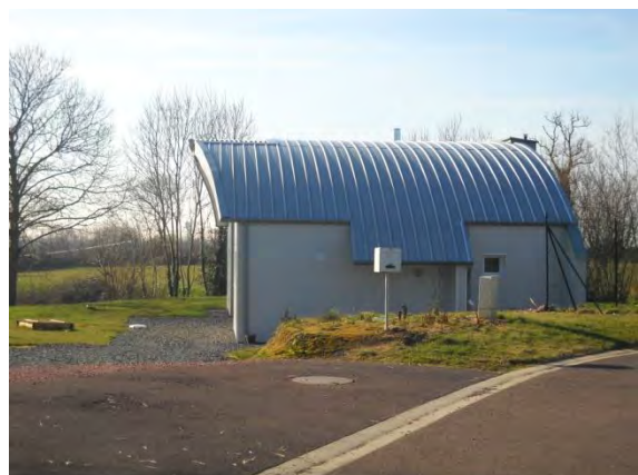
Maison neuve avec toiture en courbe
