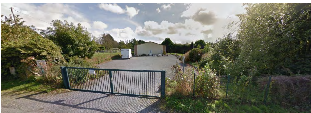
Bâtiment d'activité « Corbet Brocante Antiquités »
