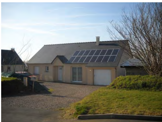
Maison neuve avec panneaux photovoltaïque, le bourg
