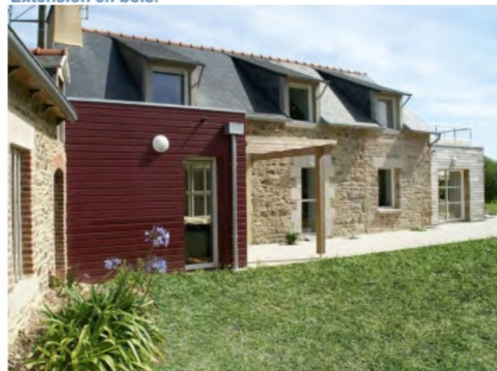
Extension en bois côté jardin et dans le prolongement de la maison.
