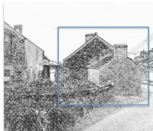
Annexe épaulant la construction principale.
