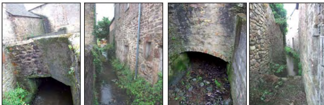
Photos n°4 à 7 , passage de la Durance et petits aménagements en pierre.
