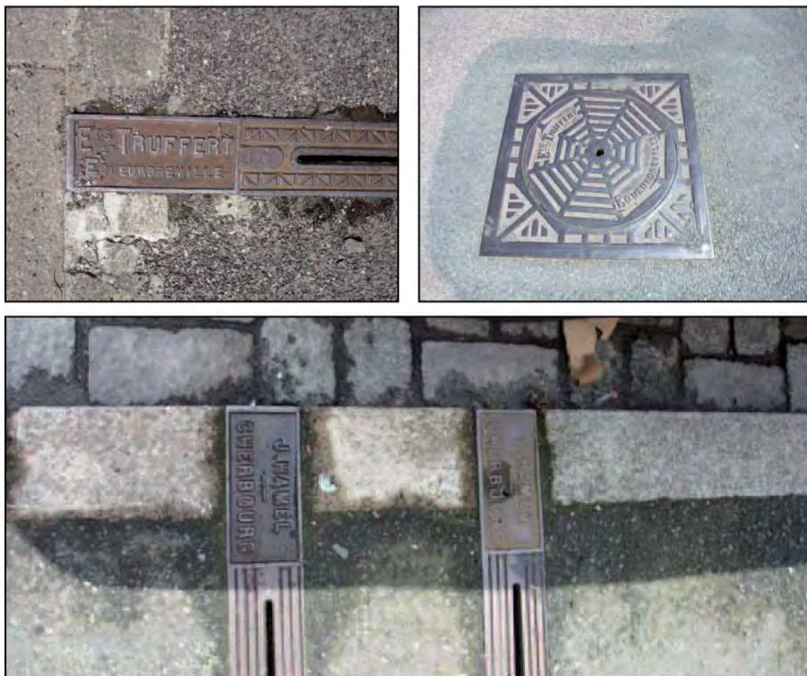
Photos de détails, regards de voirie.
