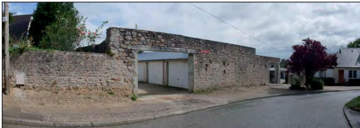
Photo montrant un remaniement récent d'un mur existant pour ouvrir un accès en cœur d'îlot pour l'utilisation de garages
