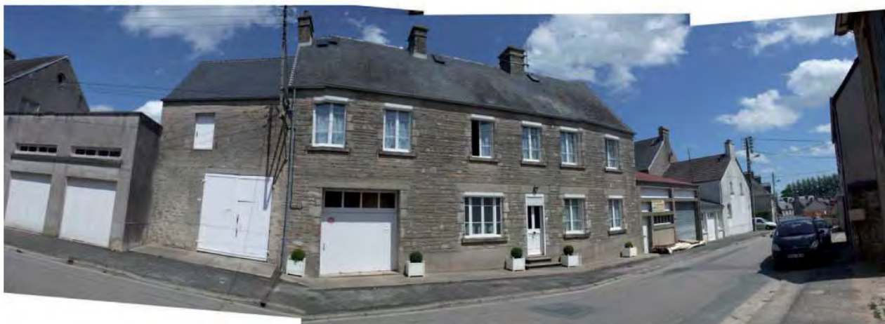
Photos du centre-ville. Îlots construits, allant du R+1+combles à R+2+combles.
