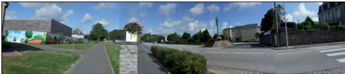
Entrée Ouest sur le tissu urbain dense de Montebourg. Entrée marquée par la présence d'un calvaire, du croisement de plusieurs voies, et d'équipements (ici salle multisport)
