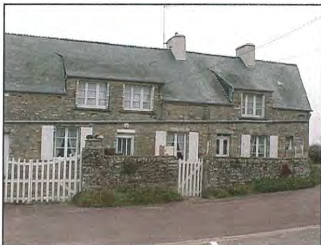
Figure 15. Bâti ancien en retrait et parallèle à la voie
