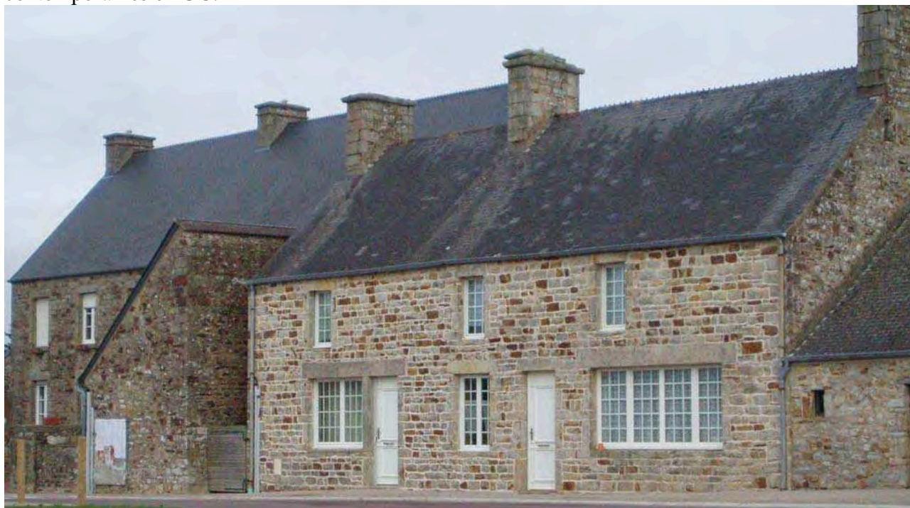
Exemple de construction traditionnelle située en zone UB
