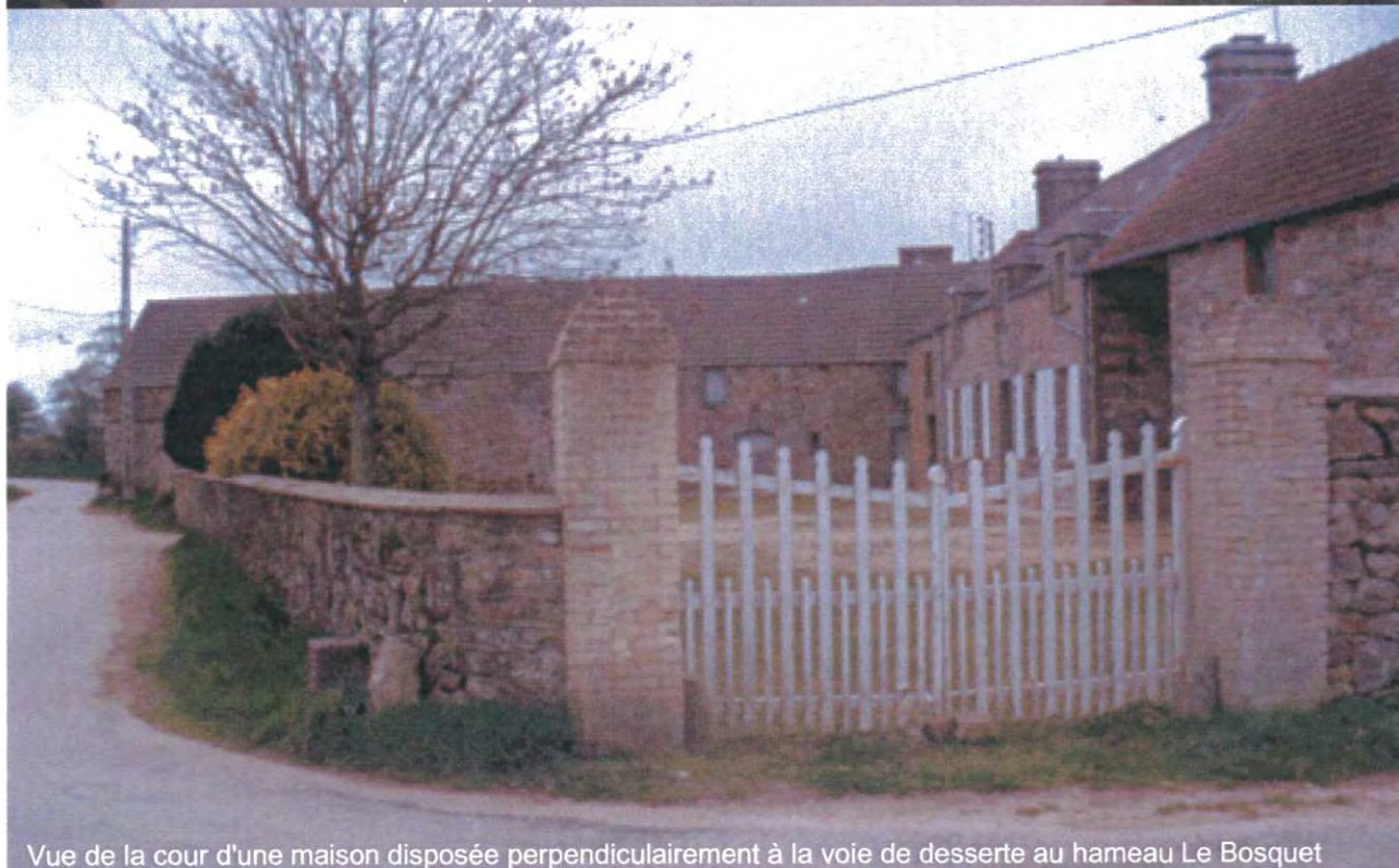
Vue de la cour d'une maison disposée perpendiculairement à la voie de desserte au hameau Le Bosquet
