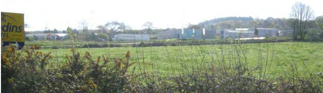
Vue vers la frange Est avec les bâtiments d'activités
