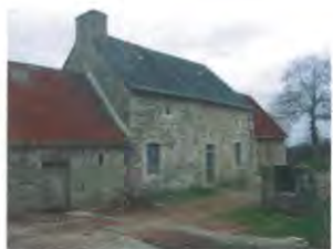
Hameau Girard – Maison en cours de réhabilitation
