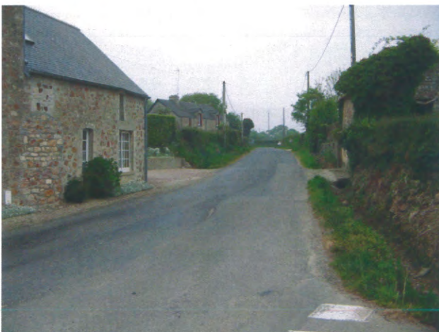
③ Accès aux parcelles n°225, n°221 et n°223 (Sud)
