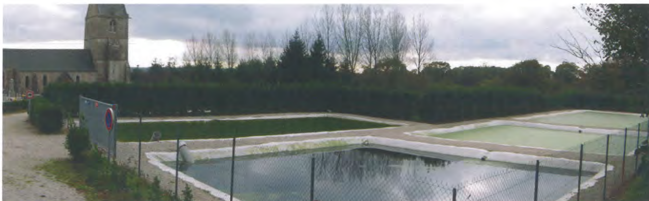
Système de lagunage pour la maison de retraite
