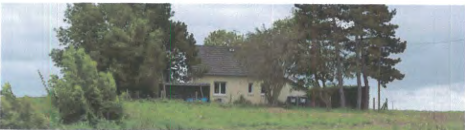
Cas n° 2 : pavillon isolé situé en zone A à l'entrée est du bourg
