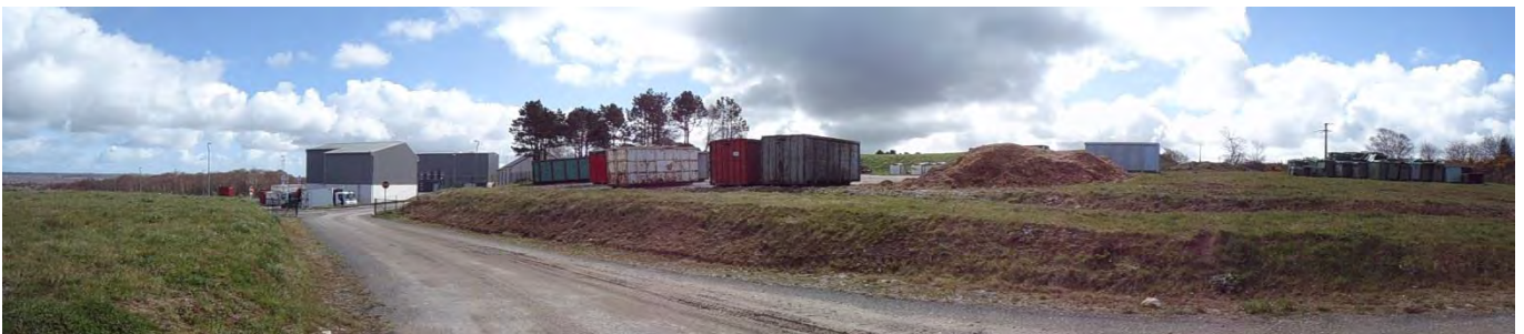
Plateforme de stockage
