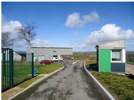
Entrée du site
