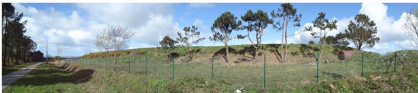
Ancienne décharge, au Sud du site
