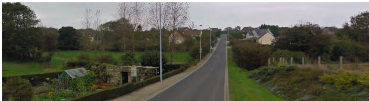
Chemin piétonnier le long de la route
