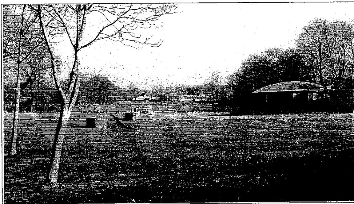
Réservoirs: captage des sources de la Diélette (sud du hameau les Fontaines)
