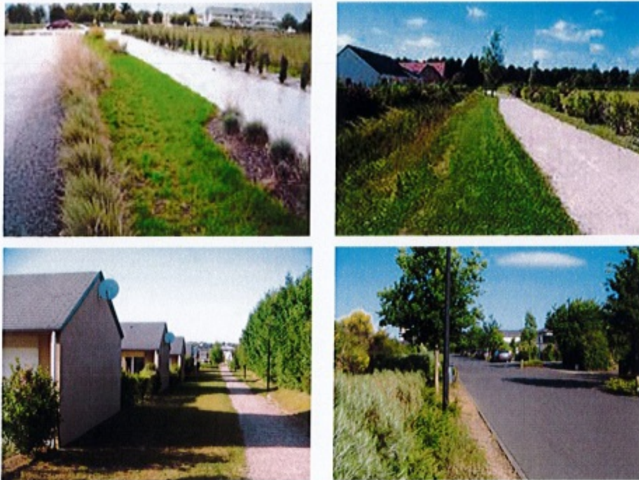
Exemples de noues paysagères et cheminements piétonniers
