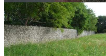
Murs la Jeannerie
