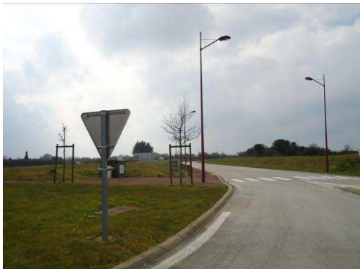
Zone d'activités en cours de réalisation
