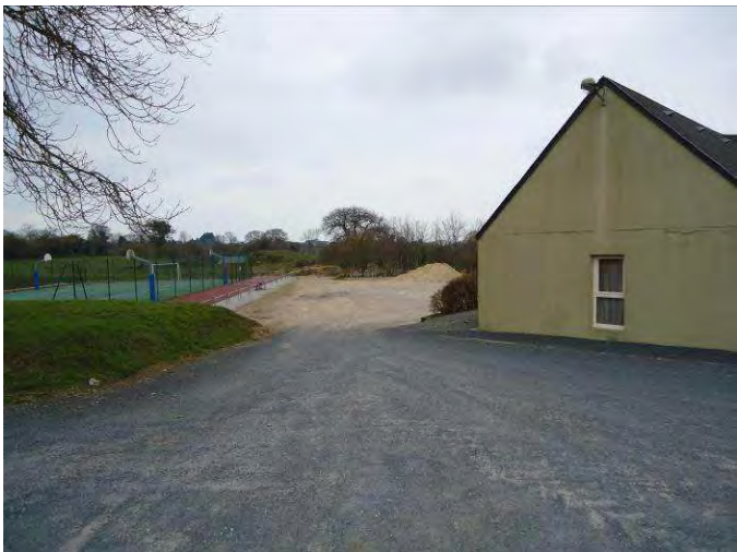
8 – Accès au parking de la salle polyvalente
