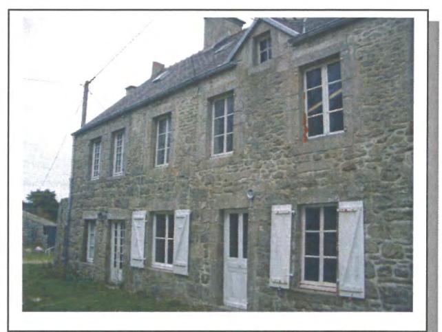
Toiture débordante avec gouttière
