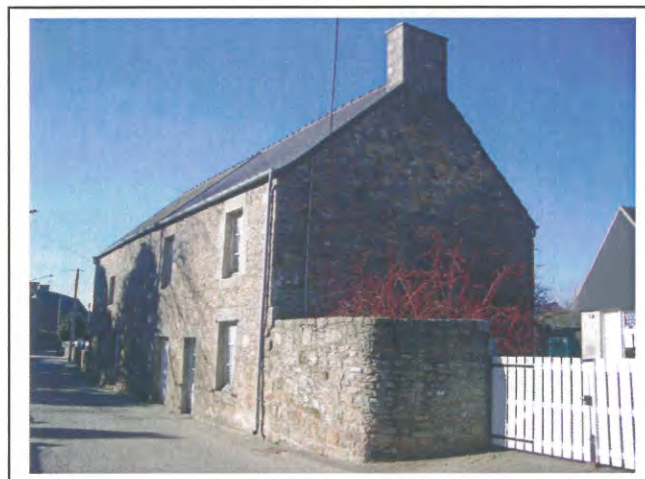
Clôture pierre et bois
