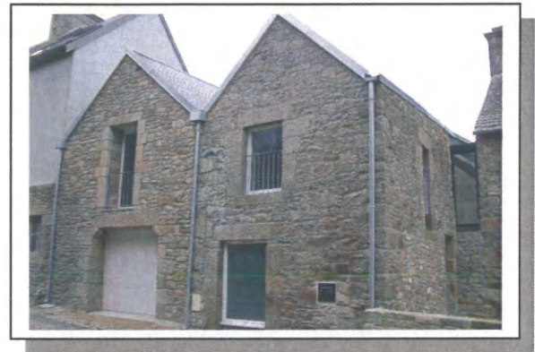
Percements – Croisées à grands carreaux
