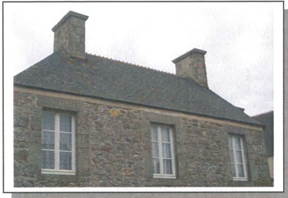
Toiture en ardoises
