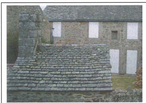
Toiture en Schistes
