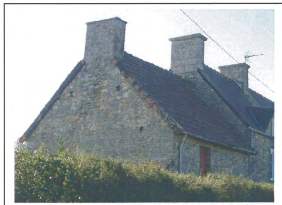
Toiture en tuiles mécaniques
