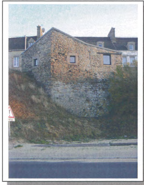
Toiture à faible pente en zinc (sous ardoise "décorative")
