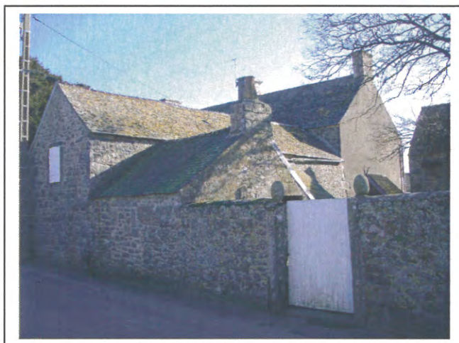
Toiture débordante sans gouttière
