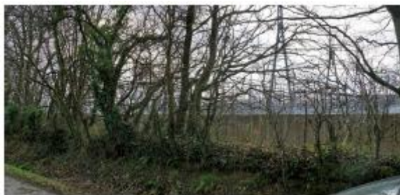
Figure 38 : Entouré par de structures bocagères, le poste électrique existant de Menuel est peu visible depuis la majeure partie de sa proche périphérie. Ici à son extrémité nord, le long de la D419, à hauteur du hameau de Rotz. (Source : Atelier de l'Isthme)
