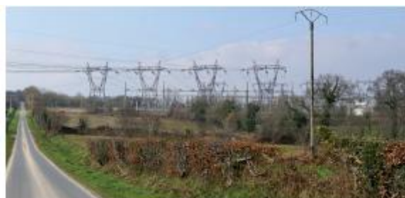
Figure 39 : Dans l'axe des faisceaux de lignes électriques 400 kV, le poste électrique est plus visible (ici en arrière des pylônes), la végétation étant régulièrement rabattue sous les lignes. (Source : Atelier de l'Isthme)
