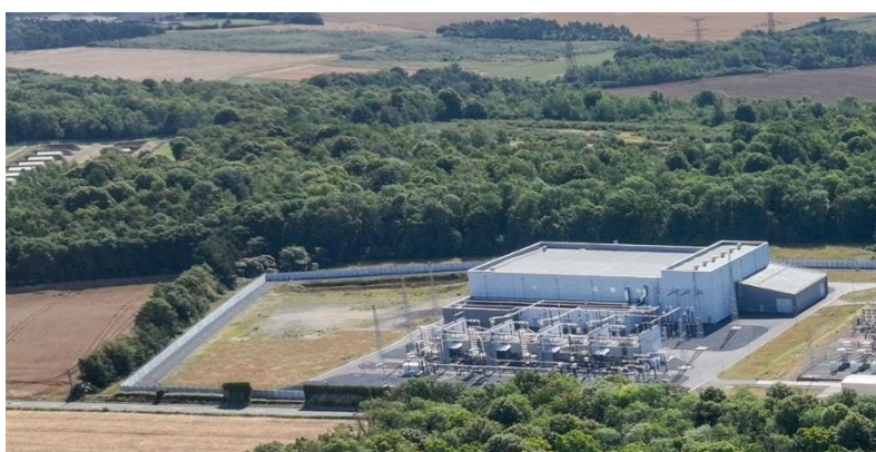
Figure 47 : Exemple d'une station de conversion à terre (Source : RTE)
