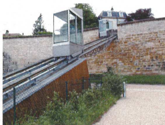
Ascenseurs d'accès à la vieille ville Langres
