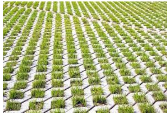
Photo : aires de stationnement perméables
