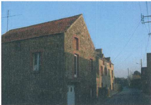
A l'entrée Sud de Vrasville: un exemple d'utilisation de tuiles en couverture, et de briques en parement, sur les linteaux et jambages des ouvertures. Les joints autour des pierres se sont épaissis.
