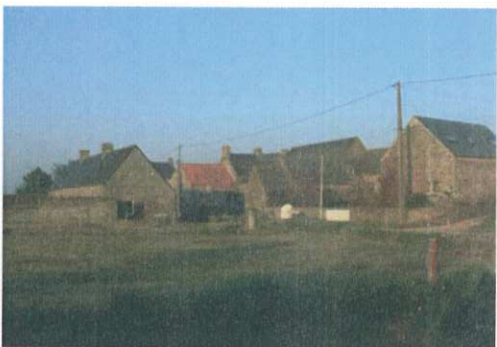
Le hameau Monnaie : Des matériaux différents commencent à affirmer une hétérogénéité.
