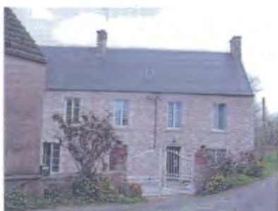
Bâtiments rénovés au Hameau de la Vicellerie
