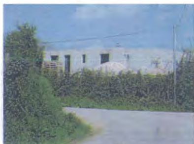
Pavillon récent en construction au Hameau Ravan
