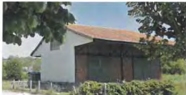
Ancienne gare et hangar de Carteret
