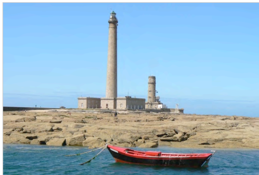
Le phare de Gatteville : l'ancienne tour de 27m (à droite) côtoie la nouvelle tour de 71m (à gauche) construite avec 11000 blocs de granite et pesant 7400 tonnes.
