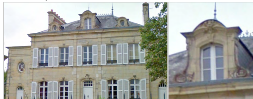
Exemple de lucarne de manoir à Barfleur : les sculptures apportent une grande qualité architecturale à l'édifice.
