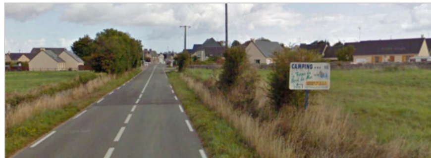
Vue depuis la D902 : des bâtis récents qui se surexposent.
