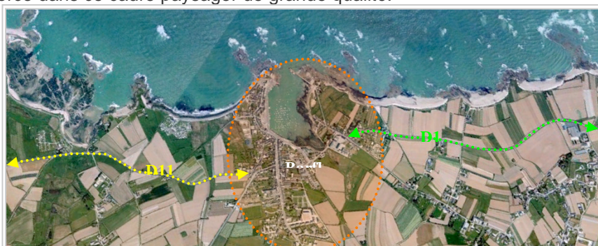
Vue aérienne du tracé des départementales D166 (en jaune) et D1 (en vert). Celles-ci bénéficient d'un contexte paysager particulièrement attractif (littoral,
