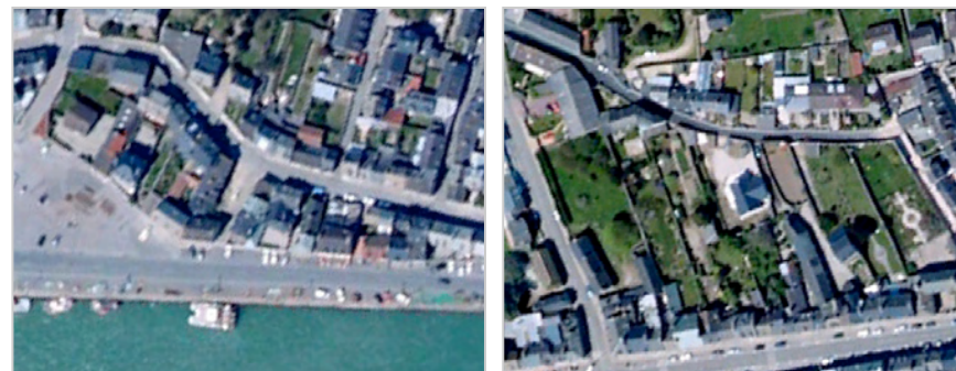
Îlots situés entre la rue Saint Nicolas et le quai Henri Chardon : un bâti dense
