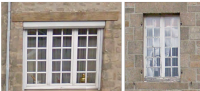
Exemples d'encadrements de baies (à gauche : linteau en bois / à droite : l'encadrement complet est en pierre de taille).
