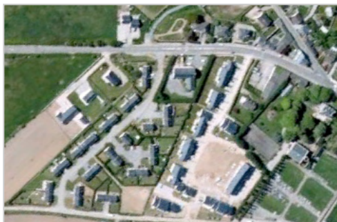
Des espaces bâtis récents qui se juxtaposent avec les espaces agricoles sans transition paysagère nuancée
