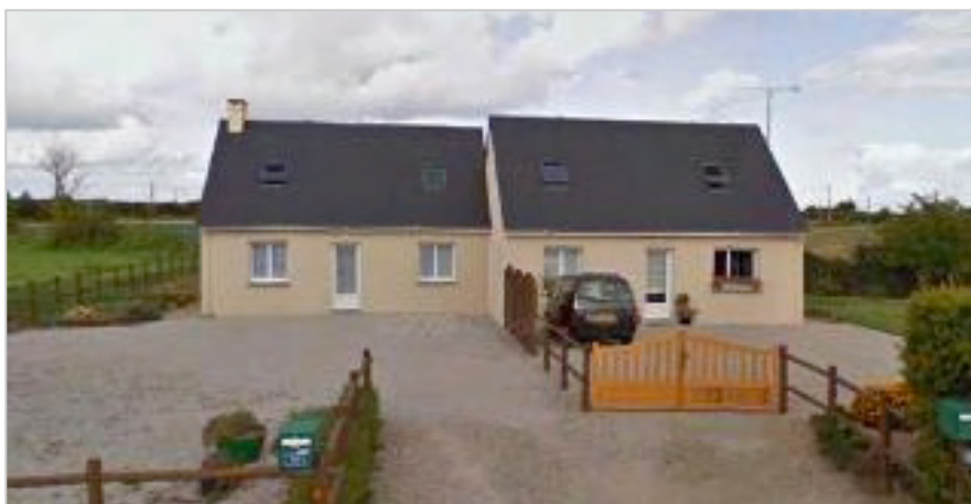
Exemples de constructions récentes sur la commune de Montfarville.
