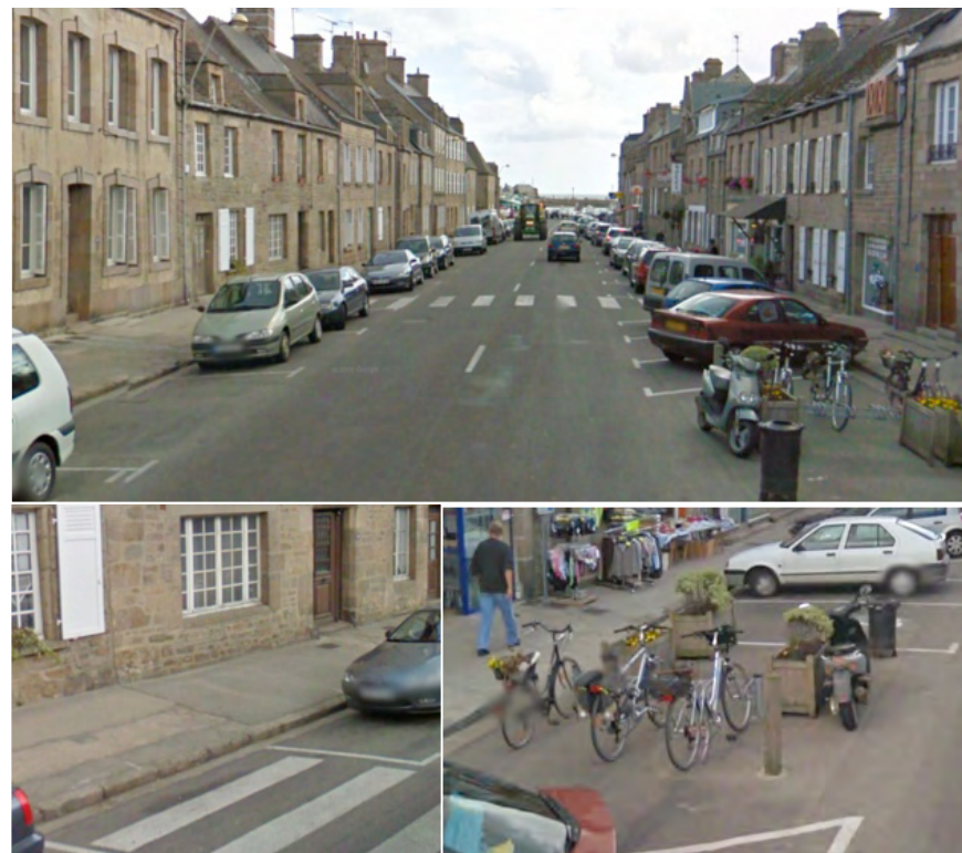
Rue Saint-Thomas Becket : des aménagements qui permettent un bon fonctionnement afin de répondre aux besoins de la population.
