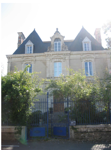
Maison de maître dans le bourg
