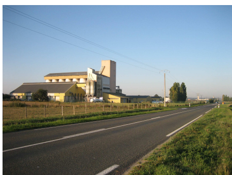
Vues des silos
