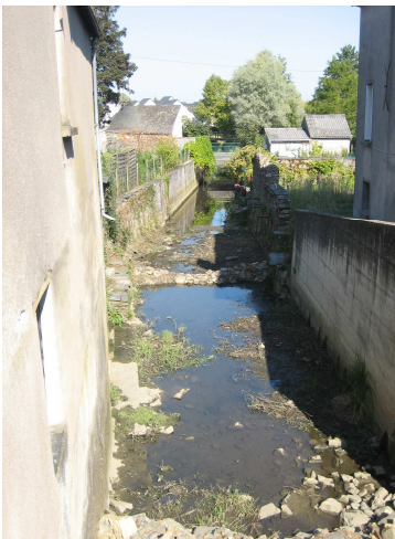
Ruisseau de l'Hommée au niveau de la RD n°770
