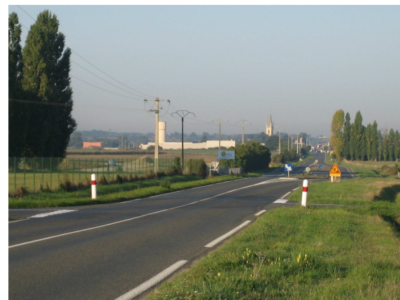
...en entrée est, une perception de la silhouette du bourg dominée par les volumes des bâtiments d'activité de la ZI des Victoires
