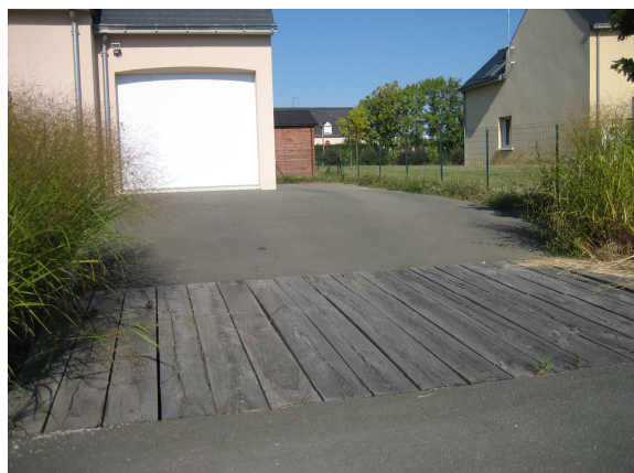
Soin dans le traitement des accès avec franchissement de noue
