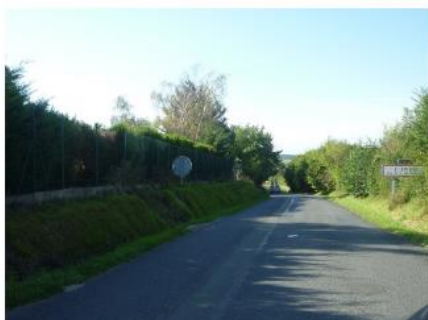
La route du Plessis le long du site (vue en direction du bourg de Saint Melaine)
