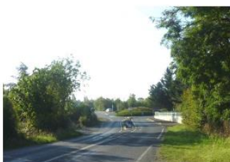
Giratoire d'accès à l'autoroute
