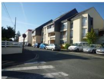
Exemple d'opération de petits collectifs sur Mûrs-Érigné
