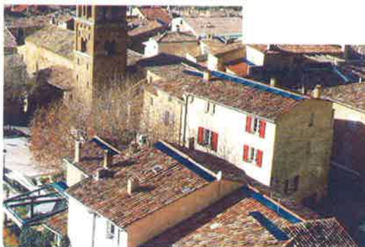
Solution acceptable en bandeaux des panneaux solaires
