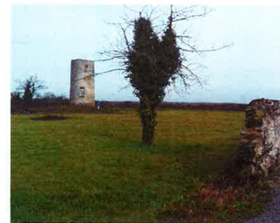
3. Vue depuis l'arrière des maisons de la rue d'Anjou sur le moulin Est
