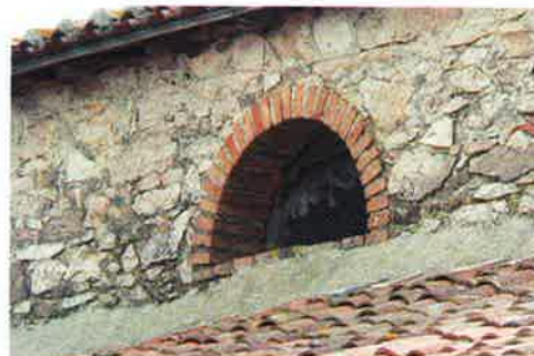
Schiste enduit sur une grange et encadrement en brique
