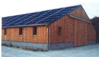
Image 1 : implantation de capteurs sur 100% de la couverture
