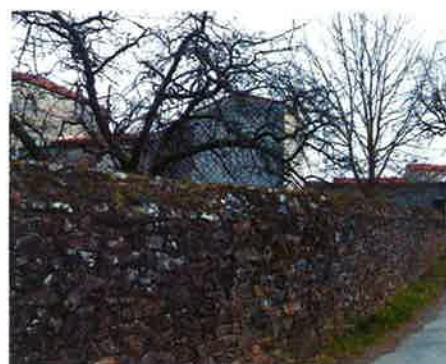
Mur et muret
