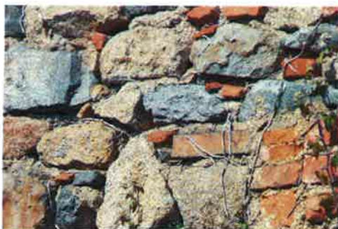
Mélange de schiste, de granit et de briques
