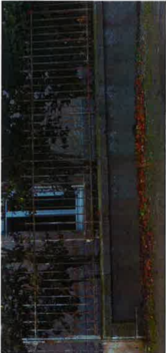
Murs bahuts surmontés d'une grille en fer forgée, avec banquette en granit
