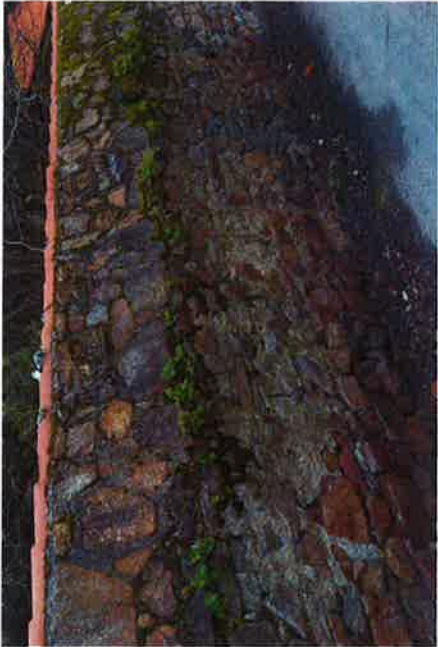
Murs en moellons terminés par un chanfrein couvert en tuiles
