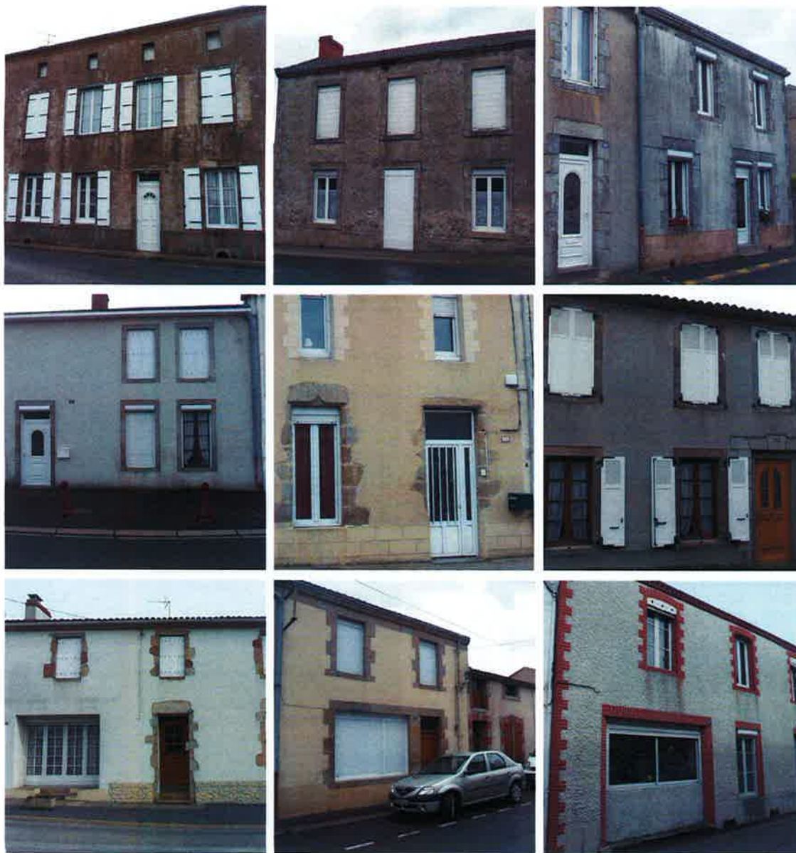
Quelques exemples de dégradation du bâti : Volets roulants, percements aux proportions inadaptées, pose d'éléments standardisés...
