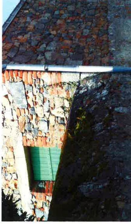
Mur de clôture et dépendance sommairement enduits
