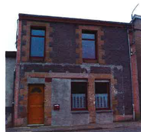
Immeuble de qualité à réhabiliter
