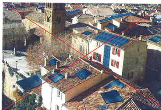
Solution tragique des panneaux solaires
