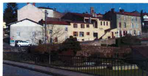
1982 : démolitions face au pont (rue Foulques Nerra)
