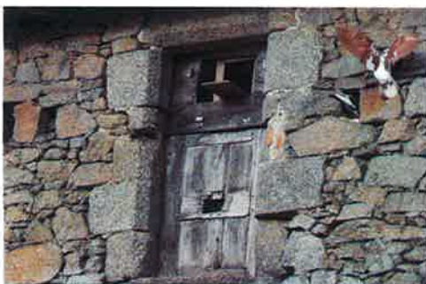
Mélange de schiste et de granit, encadrement en granit
