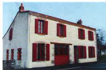
Façade principale ouverte au Sud et appentis au Nord
