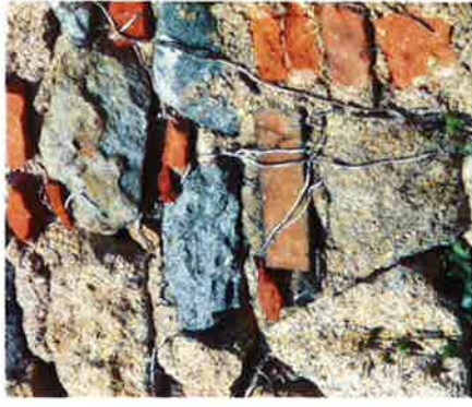
Mélange de schiste, de granit et de briques
