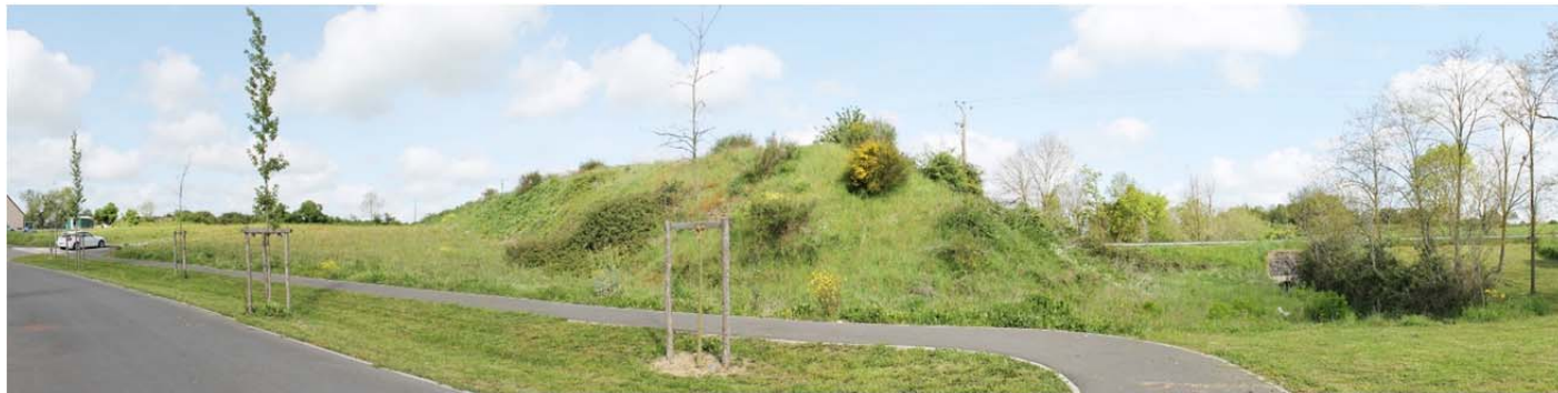
2. Vue sur le merlon mis en place au Nord-Est de la première partie du secteur
