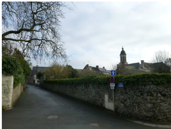
Les murs maçonnés traditionnels du cœur historique et l'église
