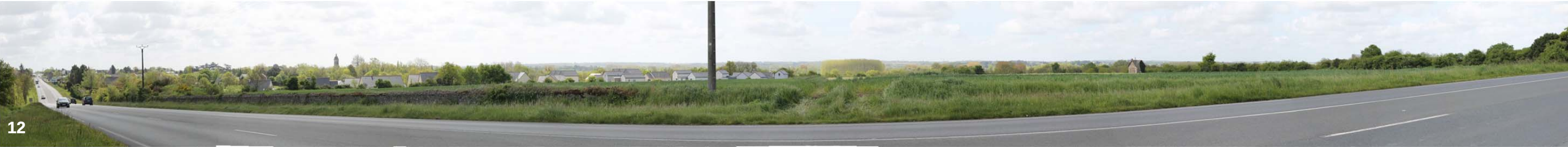
▲ Vue à 180° depuis la RD723 sur le site à urbaniser Bataflème 2
