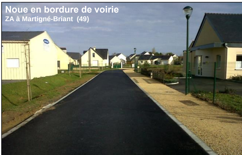
Noue dans espace vert Lotissement à Martigné-Briant (49)
