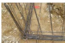
Nœud de chaînage - Continuité mécanique
