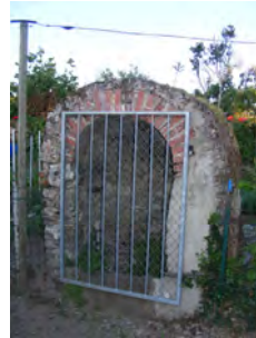
Puits passage entre le 40 et le 42 rue du Canal de Monsieur
