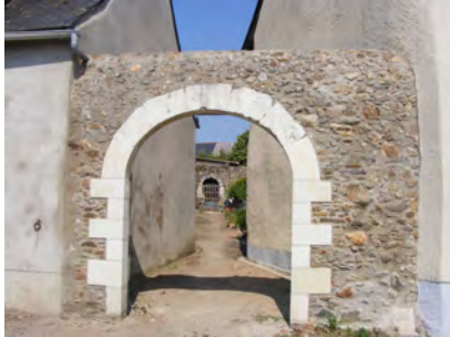
Porche et puits Les Barres
