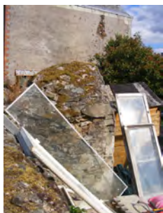
Puits chemin des Meuniers
