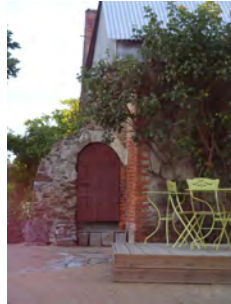
Puits 38 rue du Canal de Monsieur
