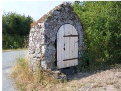
Puits chemin des Essarts
