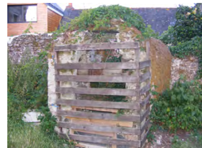
Puits et murs rue du Canal de Monsieur
