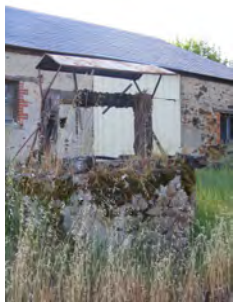
Puits rue des Louetteries
