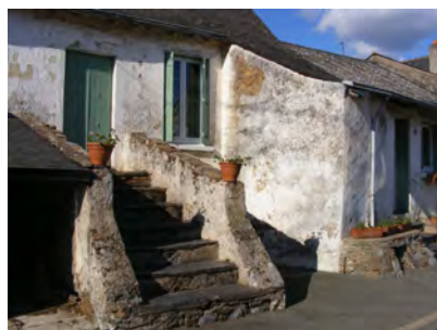
Escalier et mur de soubassement place du Pont
