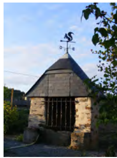
Puits rue des Louetteries
