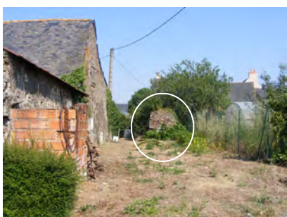
Puits chapelle Route de Rochefort
