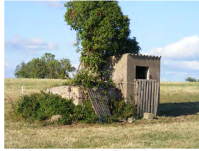
Puits entrée de la Petite Brosse
