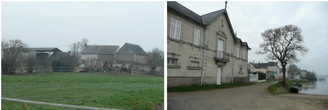
Constructions sur tertres dans la vallée (à gauche) et Les Lombardière (à droite)
