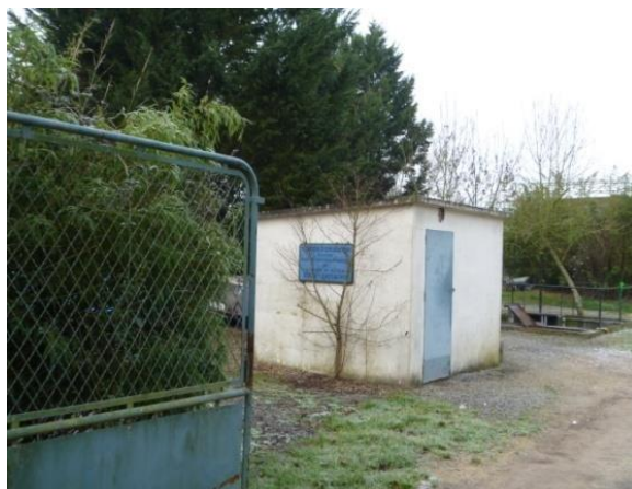
Station d'épuration du bourg
