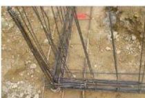
Nœud de chaînage - Continuité mécanique
