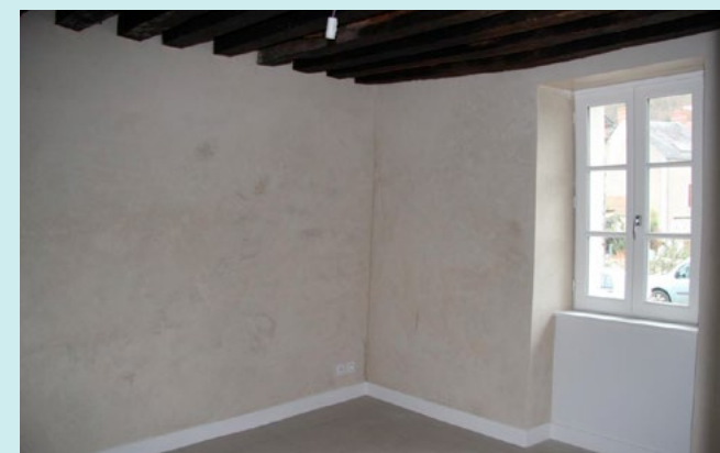
Finition par des enduits à la chaux naturelle posée sur l'enduit chaux-chanvre (Source : CREBA)
