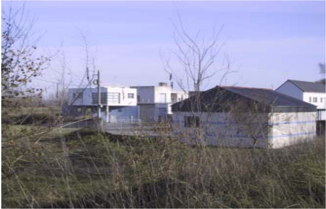
Usine d'eau potable St-Georges-sur-Loire (Photo DDE)
