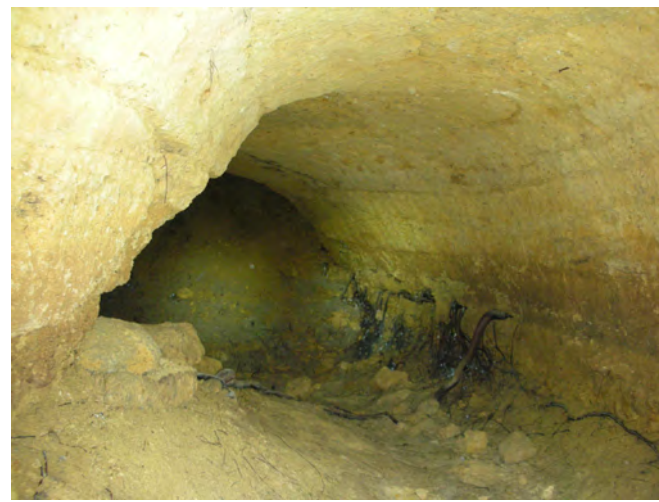
Photo 3: Ind. 002, extrémité effondrée en direction du presbytère, présence de racines
