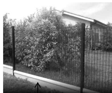
Plaque de béton en soubassement d'une clôture
