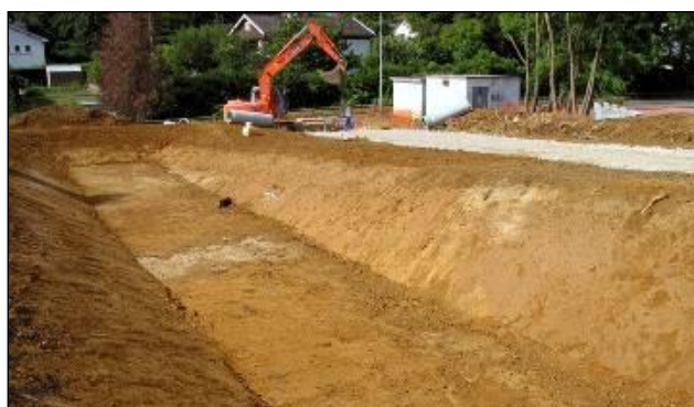
Figure 2 : Exemple de mise en place d'un bassin de rétention des eaux pluviales
