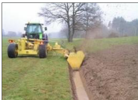
Figure 1 : Exemples de curage et reprofilage de fossé
